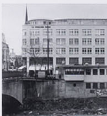
Wohn- und Geschäftshaus Stauffacher Zürich Aussersihl | 1990-1992
